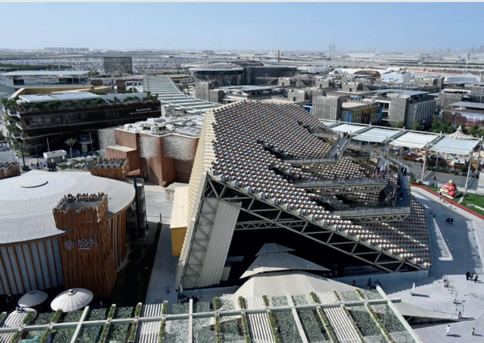
Republic of Korea Pavilion, Dubai, UAE Façade-rideau avec protection incendie EI60 avec une inclinaison de 15 degrés – forster thermfix vario
