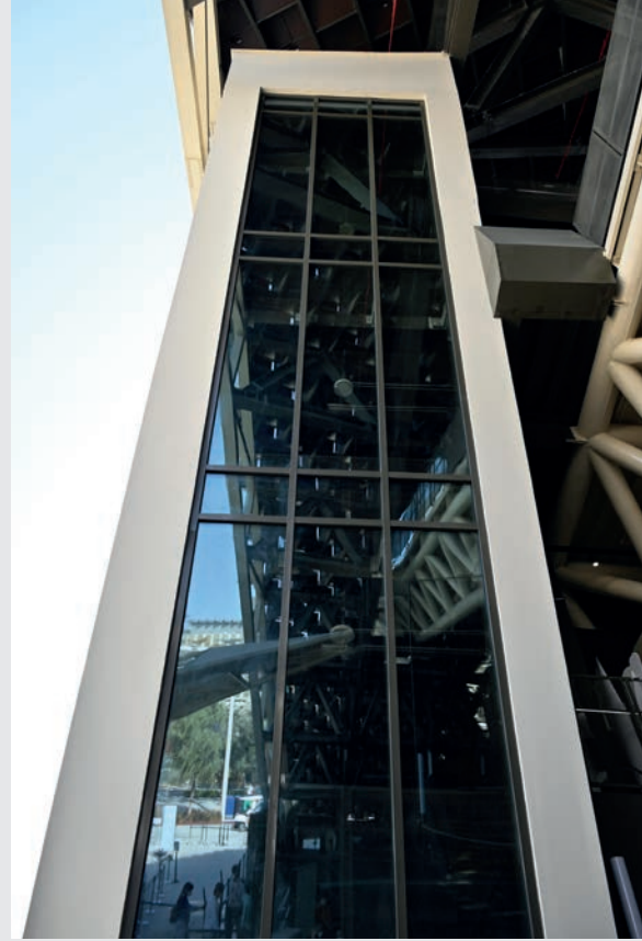
Republic of Korea Pavilion, Dubai, UAE Façade-rideau avec protection incendie EI60 avec une inclinaison de 15 degrés – forster thermfix vario
